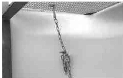
Lichtschachtsicherung (Kette) Typ 1
